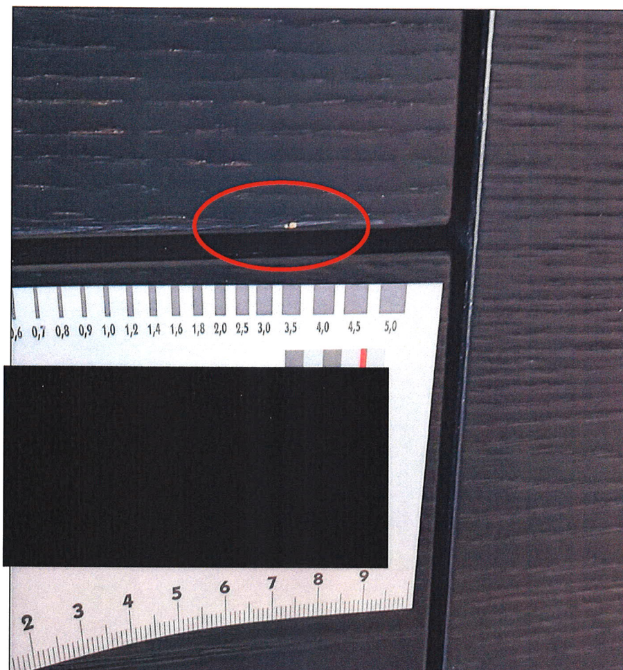
Foto Nr.: 7 Kantenschaden
